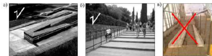
Рисунок 11 - Примеры правильного (а, б) и неправильного (в) выполнения длинных пандусов
