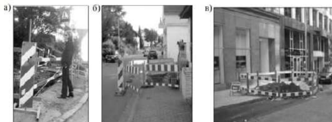
Рисунок 60 – Примеры (а, б, в) обустройства мест проведения дорожных работ ограждениями, обеспечивающими безопасность движения инвалидов
