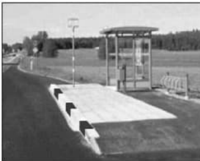
Рисунок 48 - Пример обустройства остановочного пункта пандусом
