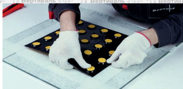
ЭТАП #3 Укладка плитки
