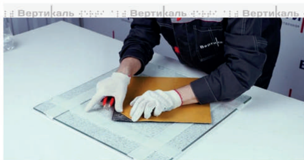
ЭТАП #2 Снимаем защитную пленку
