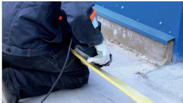
1. Подготавливаем необходимый метраж продукции из композитного материала. При необходимости отрезаем нужную длину тактильной шлицы.
