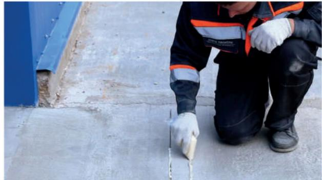
5. Укладываем композитное изделие в пазы, заполненные клеем, и устанавливаем на его поверхность прижимы в виде тяжёлого груза.
