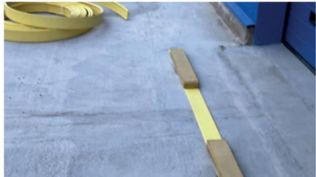
Монтаж шлицы с закладными элементами закончен. Теперь необходимо дождаться полного застывания клея. Это произойдёт примерно через 24 часа после монтажа, затем необходимо убрать прижимы с поверхности шлицы. Благодаря данному элементу тактильной навигации можно двигаться вдоль перрона железнодорожного транспорта или метрополитена, изделие выступает в роли ограничительной линии.
