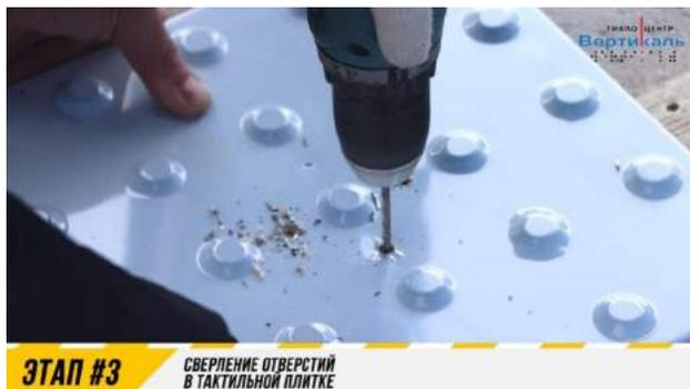
3. Шуруповёртом с тонким сверлом прodelываем отверстия в тактильной продукции. Для вашего удобства прорези для сверления уже обозначены в нужных местах в процессе производства. В качестве подложки можно использовать деревянный брус.
