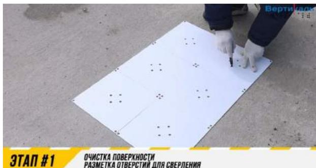
1. Очищаем поверхность, на которой планируется установка плитки, от пыли и грязи, размечаем отверстия для сверления при помощи обычного маркера и демпфера.
