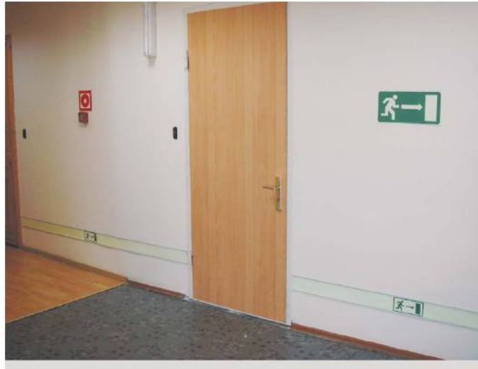
Рисунок А.8 - Вариант компоновки ФЭС
